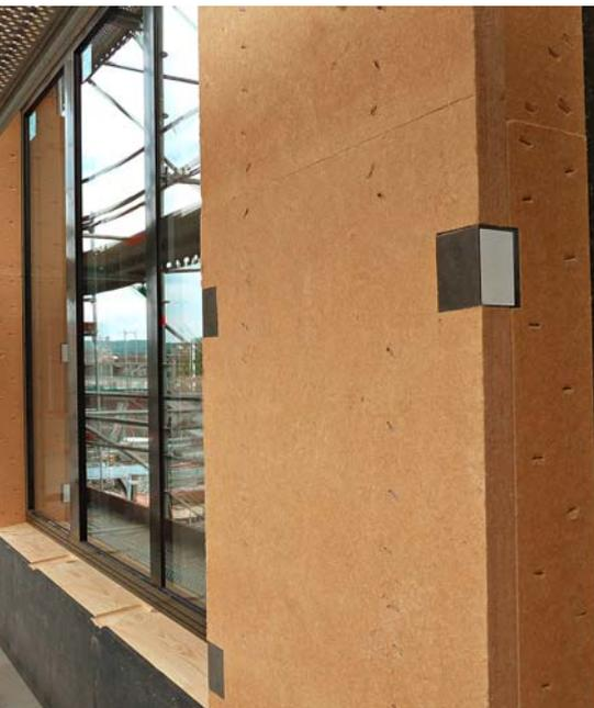
Die 60 mm starke Schicht aus Pavatex Diffutherm sorgt für Schutz vor Kälte, Hitze, Schall und Brandgefahren. (Foto: Pavatex)
