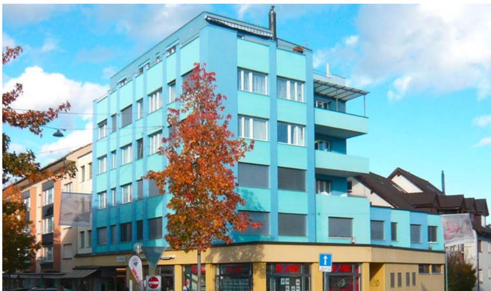
**Plusenergie-Sanierung eines 1961 erbauten Wohnhauses in Romanshorn durch das Architekturbüro Viridén+Partner AG (vorher/nachher). Im Zuge der Erneuerung wurde das Gebäude verdichtet und auf dem Dach und an den Fassaden mit Photovoltaik-Modulen ausgestattet. (Foto: Viridén + Partner AG, Zürich)**
