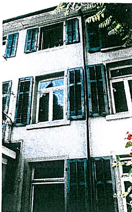
Rückfassade vor der Erneuerung
